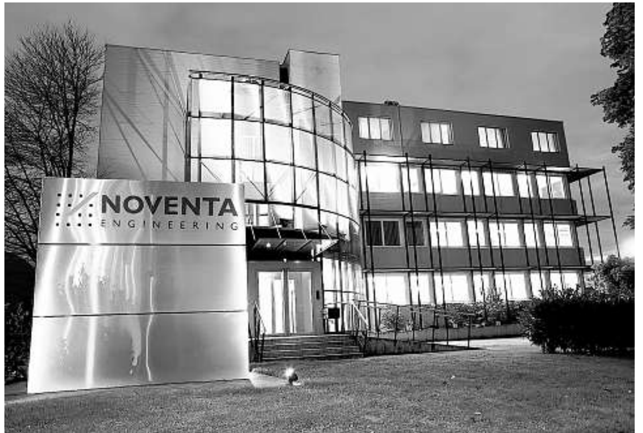
Neuen Weg eingeschlagen: Die Noventa Engineering AG in Diepoldsau hat sich ganz der Kaizen-Philosophie verschrieben.
